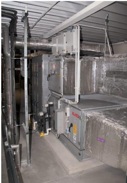
Das Technikgeschoss unter dem Dach beherbergt die Zentrallüftungsanlage und die insgesamt sieben Elektrowärmepumpen.
